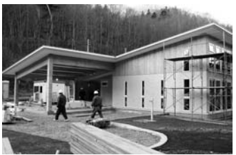
外構工事がほぼ終了した留真温泉。
