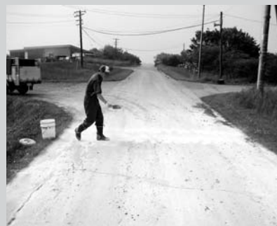
消石灰の散布作業をする模範牧場職員。
