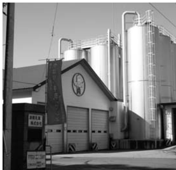
施設の建て替えが決まった浦幌乳業
