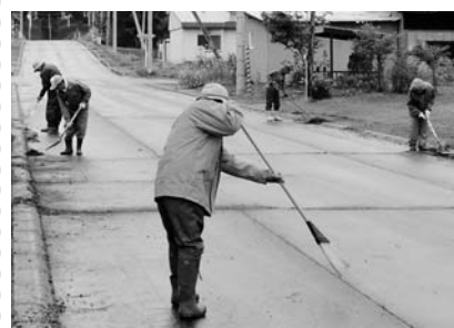
清掃作業を行う西江建設関係者と住民
