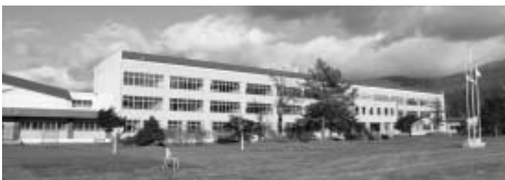
耐震強度不足とされる浦幌中学校校舎
