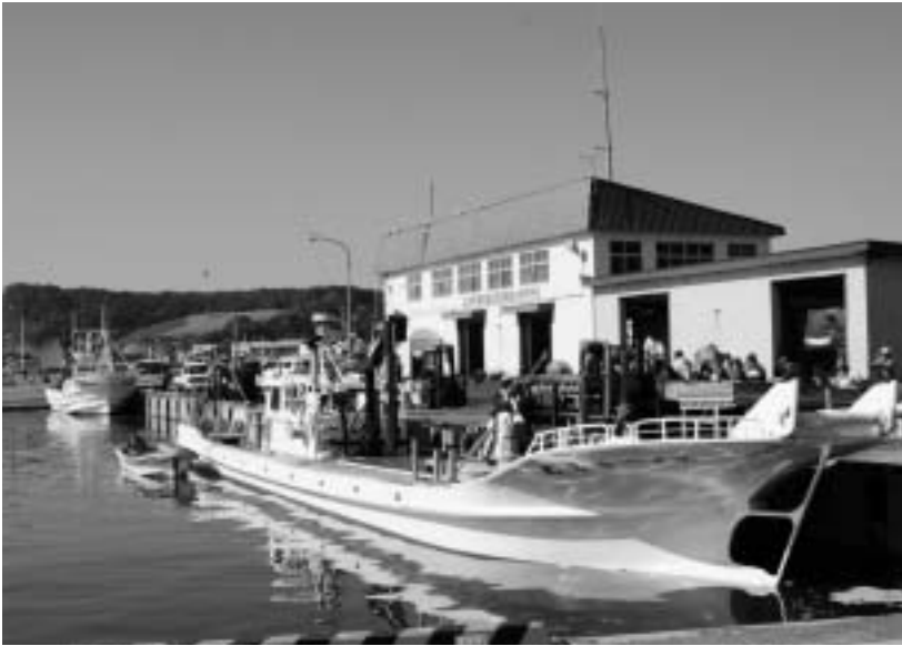
係留場岸壁の補修工事が進められる厚内漁港
